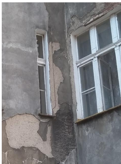
Fot. 3. Widok opaski okiennej na elewacji podwórzowej.
