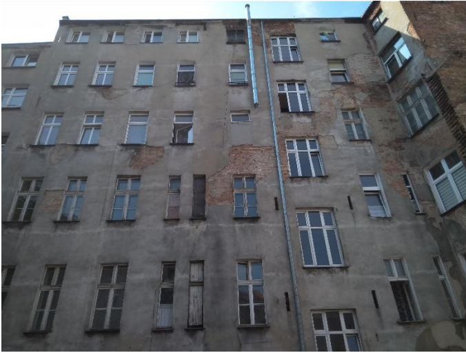
Fot. 1. Widok na elewację podwórzową.
