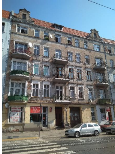
Fot. 2. Widok na elewację frontową.
