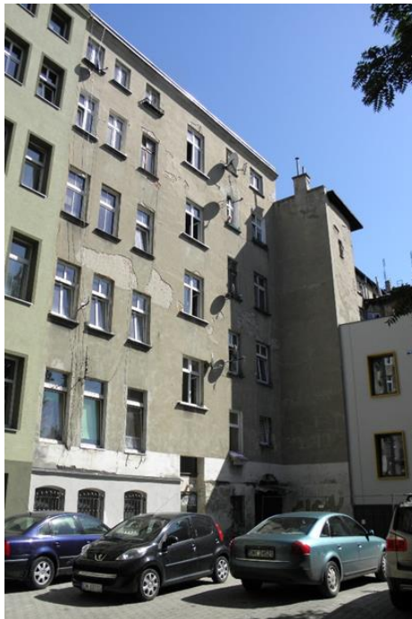
Fot. 2 – Elewacja podwórzowa
