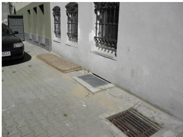
Fot. 3 – Nawierzchnia z kostki betonowej – elewacja podwórzowa
