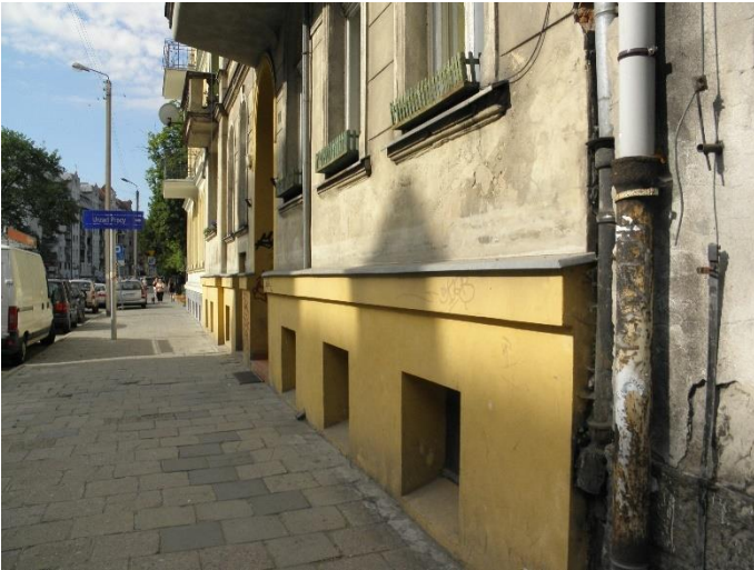
Fot. 4 Chodnik od strony elewacji frontowej.
