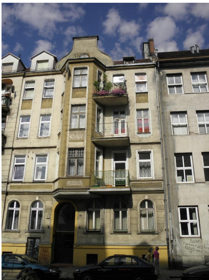
Fot. 1. Widok na elewację frontową.
