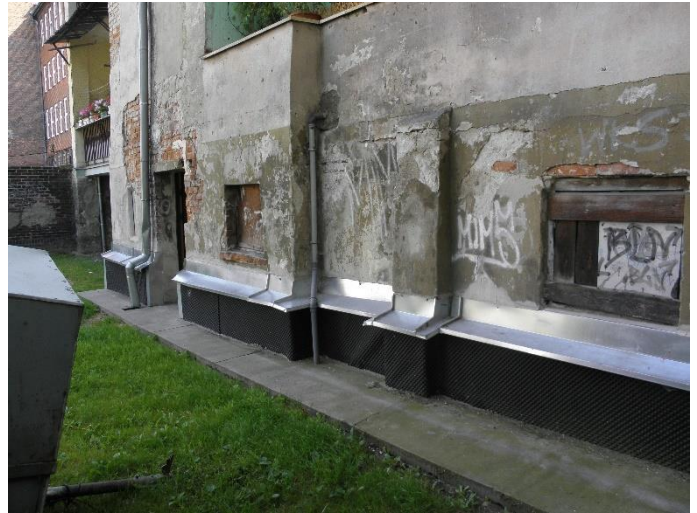
Fot. 4 Nawierzchnie betonowe od strony elewacji podwórzowej.
