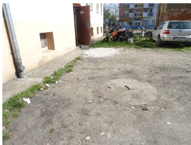
Fot. 3 - Nawierzchnie betonowe - elewacje podwórzowe
