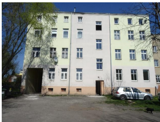
Fot. 2 – Elewacje podwórzowe
