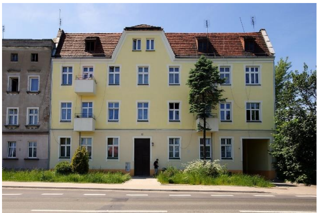
Fot. 1 - Elewacja frontowa
