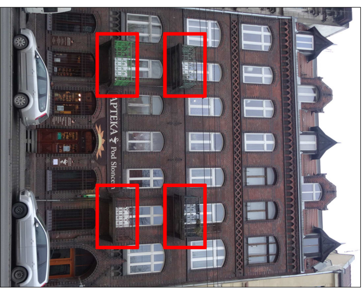
ELEWACJA FRONTOWA BALCONY DO REMONTU
