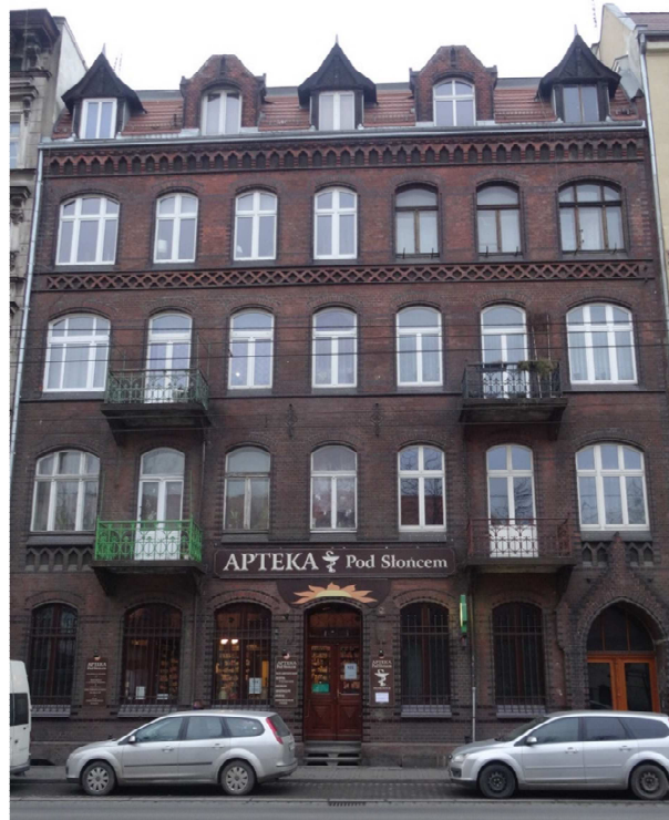
Fot. nr 1 Widok ogólny elewacji frontowej
