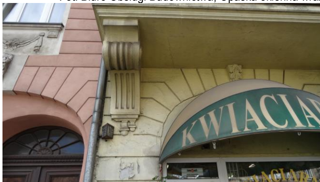
Fot. Biuro Obsługi Budownictwa, Konsola i fragment boniowania oraz dekoracja pasa międzyokiennego.
