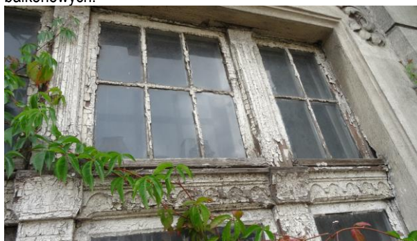
Fot. Biuro Obsługi Budownictwa, Widok na fragment okna drewnianego, ooryginalnego.
