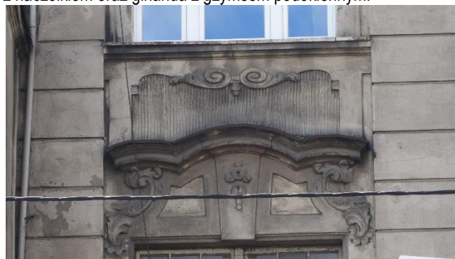
Fot. Biuro Obsługi Budownictwa, Konsola i fragment boniowania oraz dekoracja pasa międzyokiennego.
