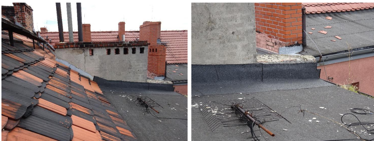
Fot. Biuro Obsługi Budownictwa, Kominy kamienicy objętej opracowaniem oraz w tle kominy kamienicy Traugutta 109.
