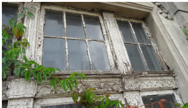
Fot. Biuro Obsługi Budownictwa, Widok na fragment okna drewnianego, oryginalnego.
