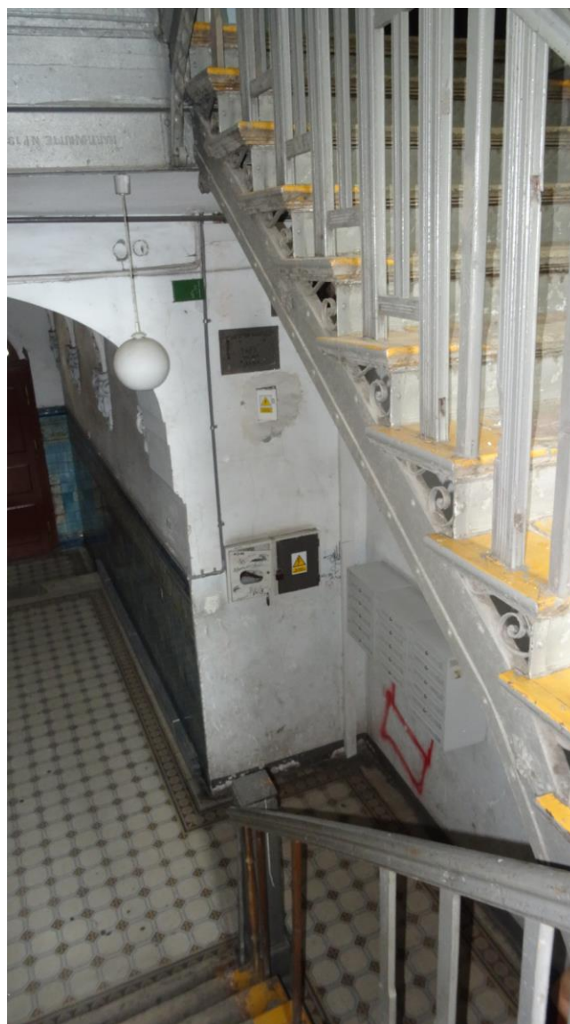
Fot. Biuro Obsługi Budownictwa, Widok na bieg schodów oraz fragment sieni
