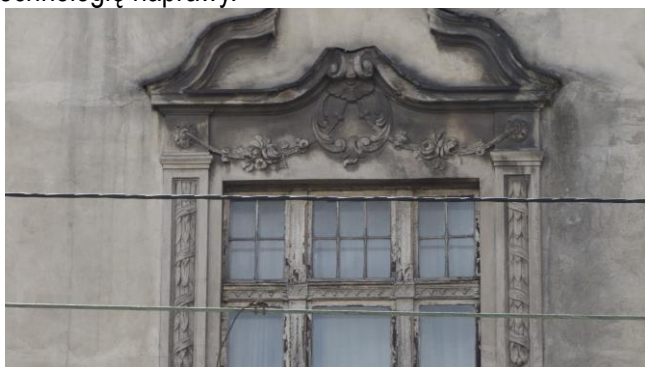
Fot. Biuro Obsługi Budownictwa, Opaska okienna wraz z naczółkiem oraz girlanda z gzymsem podokiennym.
