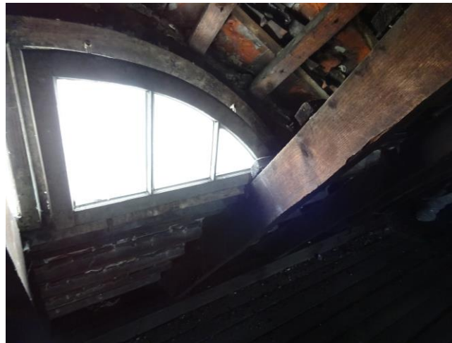
Fot. Biuro Obsługi Budownictwa, widok na fragmenty krokwi oraz łąt.
