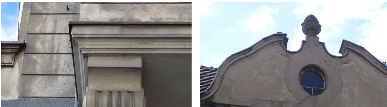
Fot. Biuro Obsługi Budownictwa, Gzyms spodu wykusza i płyty balkonowej oraz profilowane wykończenie szczytu elewacji.
