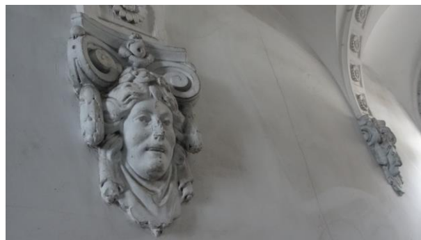
Fot. Biuro Obsługi Budownictwa, Widok na płytki w sieni oraz przedstawienia głów.
