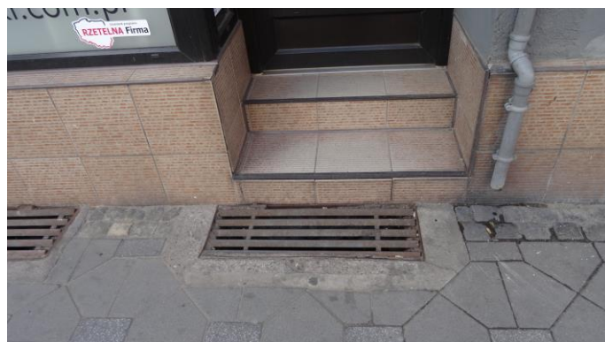
Fot. Biuro Obsługi Budownictwa, nawierzchnia od strony elewacji frontowej- płytki gresowe do skucia
