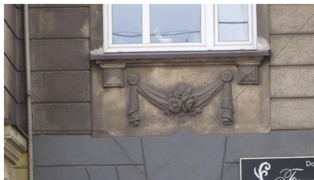
Fot. Biuro Obsługi Budownictwa, Opaska okienna wraz z naczółkiem oraz girlanda z gzymsem podokiennym.
