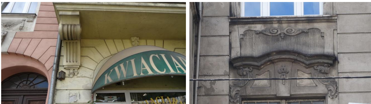
Fot. Biuro Obsługi Budownictwa, Konsola i fragment boniowania oraz dekoracja pasa międzyokiennego.
