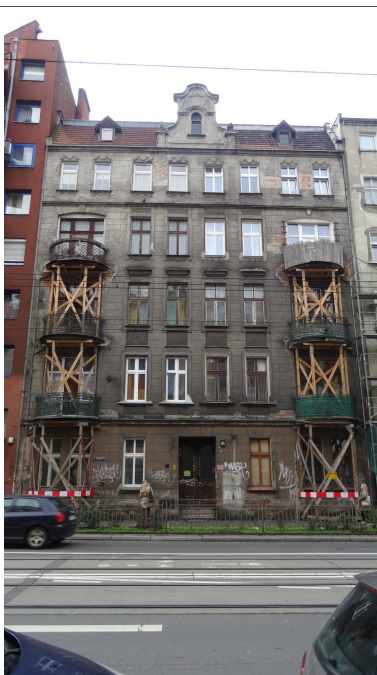
Fot.1 Elewacja frontowa
