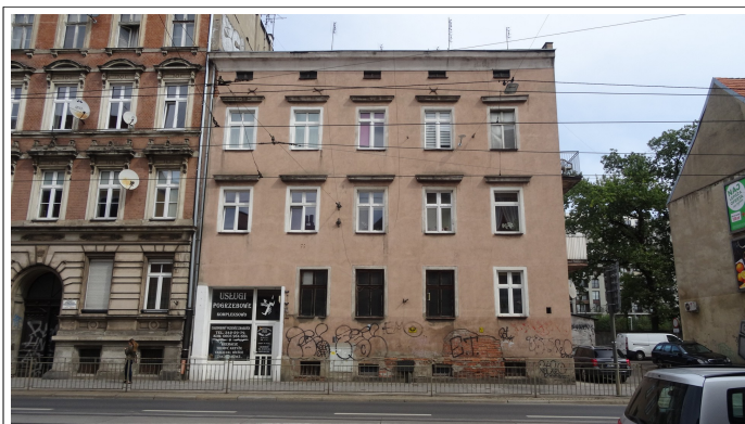
Fot.1 Elewacja frontowa
