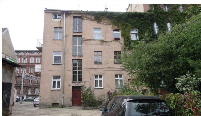
Fot. 2 Elewacja podwórzowa
