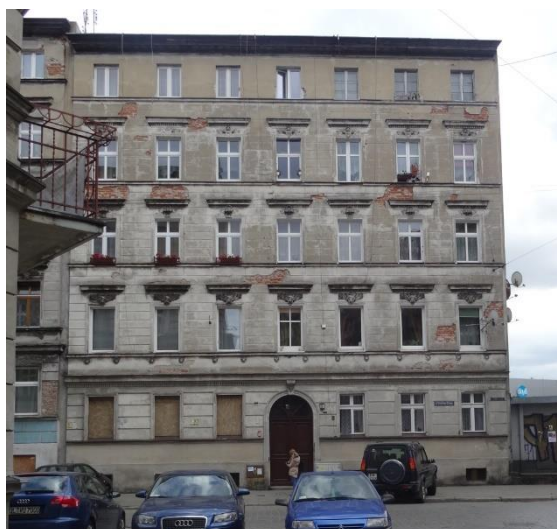
Fot. 1 - Elewacja frontowa
