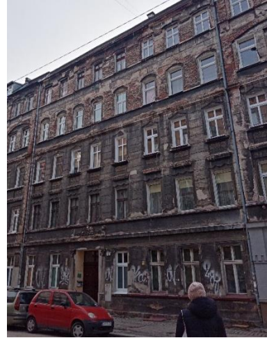
Zdj. 2 Widok na elewację frontową od str. ul. Świstackiego
