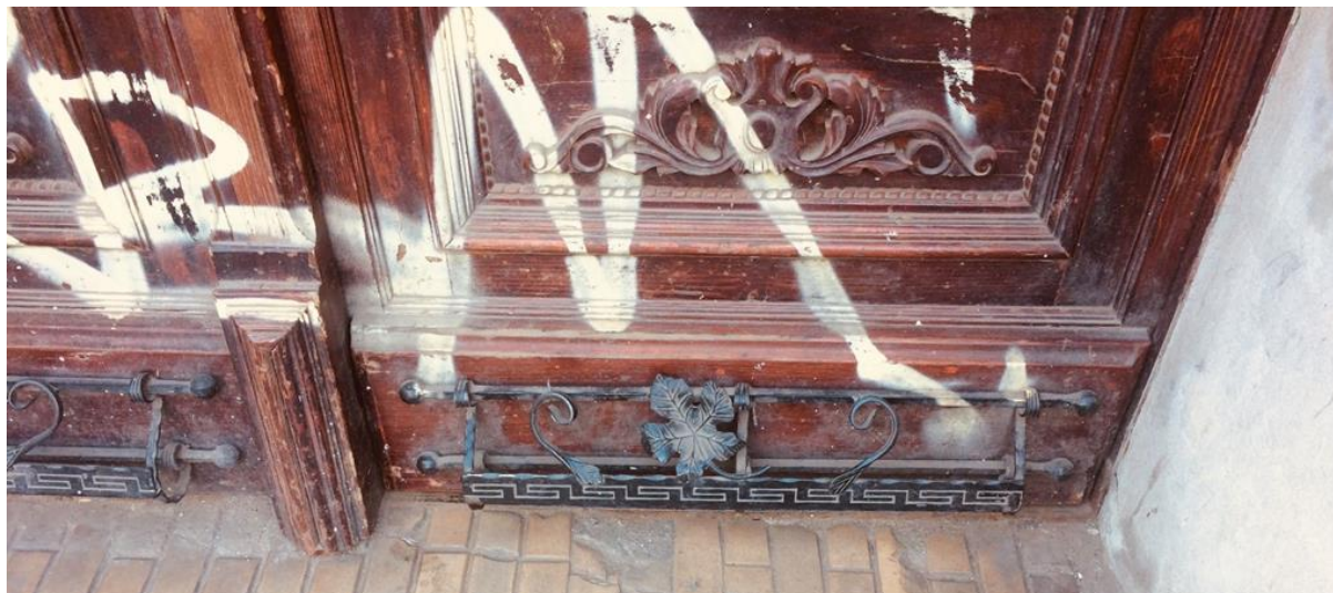
Fot 10 – Przykład wykonania elementu metaloplastycznego
