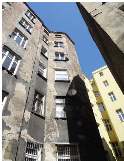
Fot. 3 – Elewacje podwórzowa
