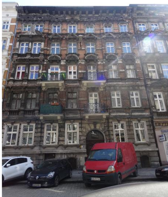
Fot. 2 – Elewacja frontowa
